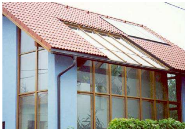
Wintergarten, im Haus integriert
