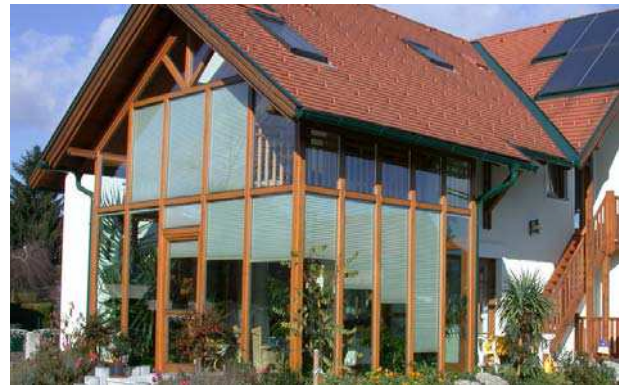
Saniertes Althaus mit Wintergarten
